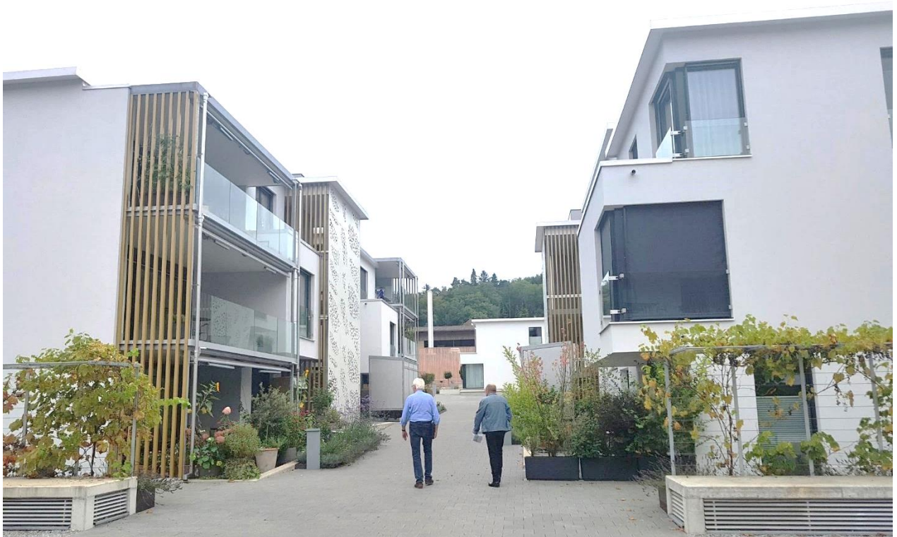
Abbildung 1 «Gasse» zwischen Baufeldern 1, 2 und 9, 10; Begehung September 2021
